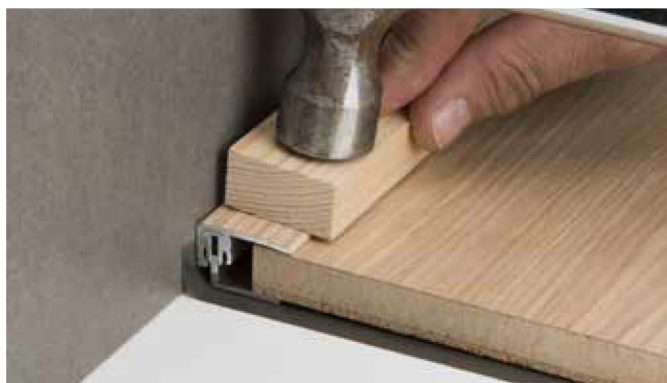
Instalace ukončovacího profilu hliníkového
